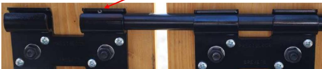
L'avantage de ce système est aussi que les barres ne s'égarer plus et restent sur le volet lorsque celui-ci est ouvert.
